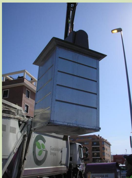
En el hueco del contenedor queda una plataforma móvil que impide la caída accidental de personas al foso. Esta plataforma baja por el peso del contenedor e impide que se abran las puertas ante un enganche accidental de la anilla que abre las mismas y sube por la acción de dos pesas sujetas a dos poleas en dos laterales enfrentados.
